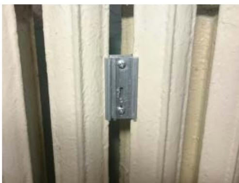
2. Навесить сверху распределитель на тепловой адаптер, нажать на нижнюю часть и защелкнуть пломбу, входящую в комплект поставки.
